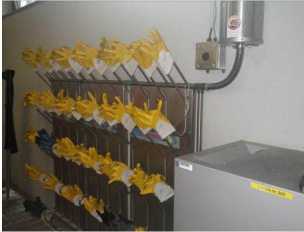
Beispiel: Trocknungsanlage für gereinigte Handschuhe (Quelle: BWB)
