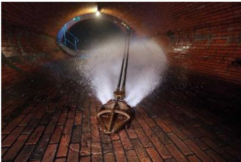
Maschinelles Reinigungsverfahren (Quelle: BWB)
