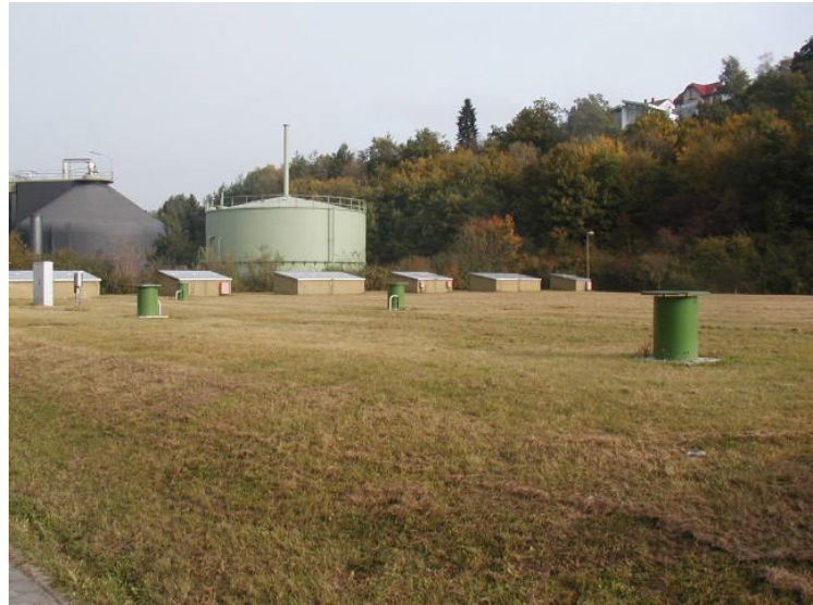
Beispiel: Einhausung eines Schneckenpumpwerks / Abdeckung eines Belebungsbeckens. (Quelle: DAR)
