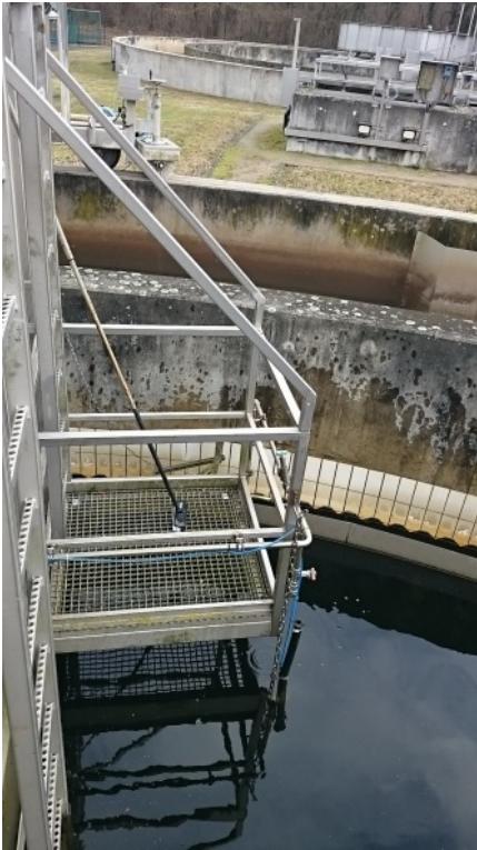
Gesicherter Standplatz an Beckenanlage (Quelle: DAR)
