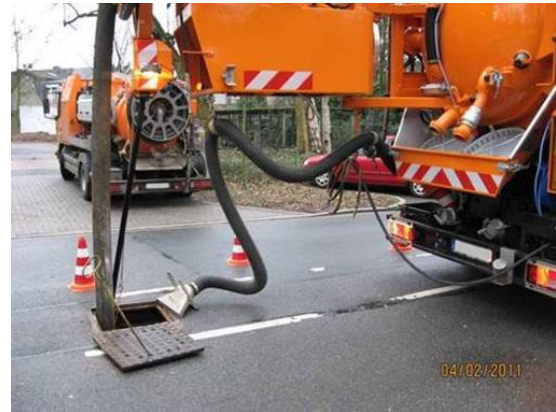
Beispiel: Kanalreinigung mit HDS-Fahrzeugen – Luftschleierabspernung (Quelle: TRBA 220, WSW)
