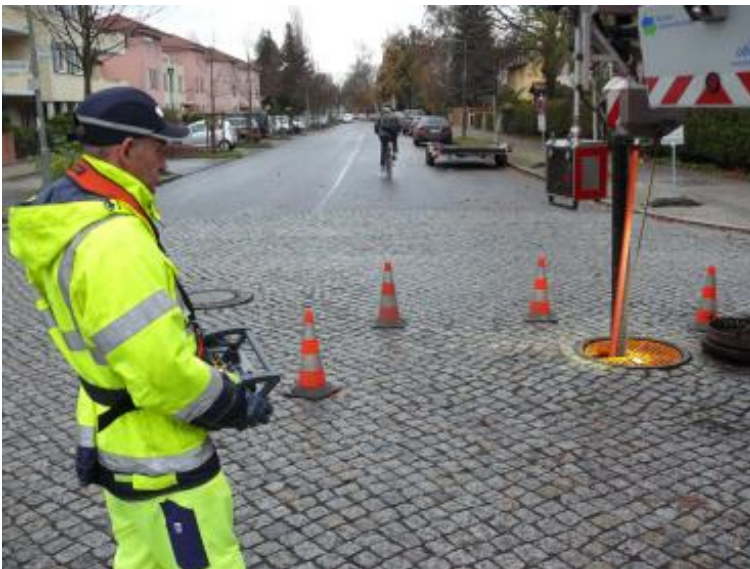
Reinigungsarbeiten mit sicherem Abstand (Quelle: BWB)
