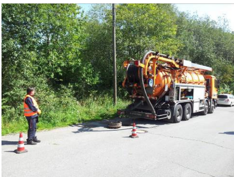
Beispiele: Hochdruckkanalspülung mit Fernbedienung (Quelle: WSW, BWB)
